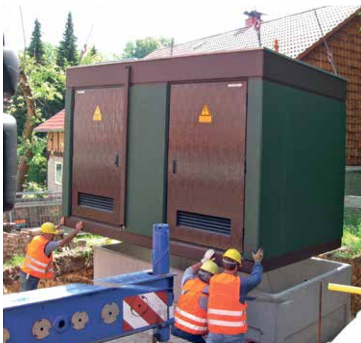
Setzen einer 20kV Station
